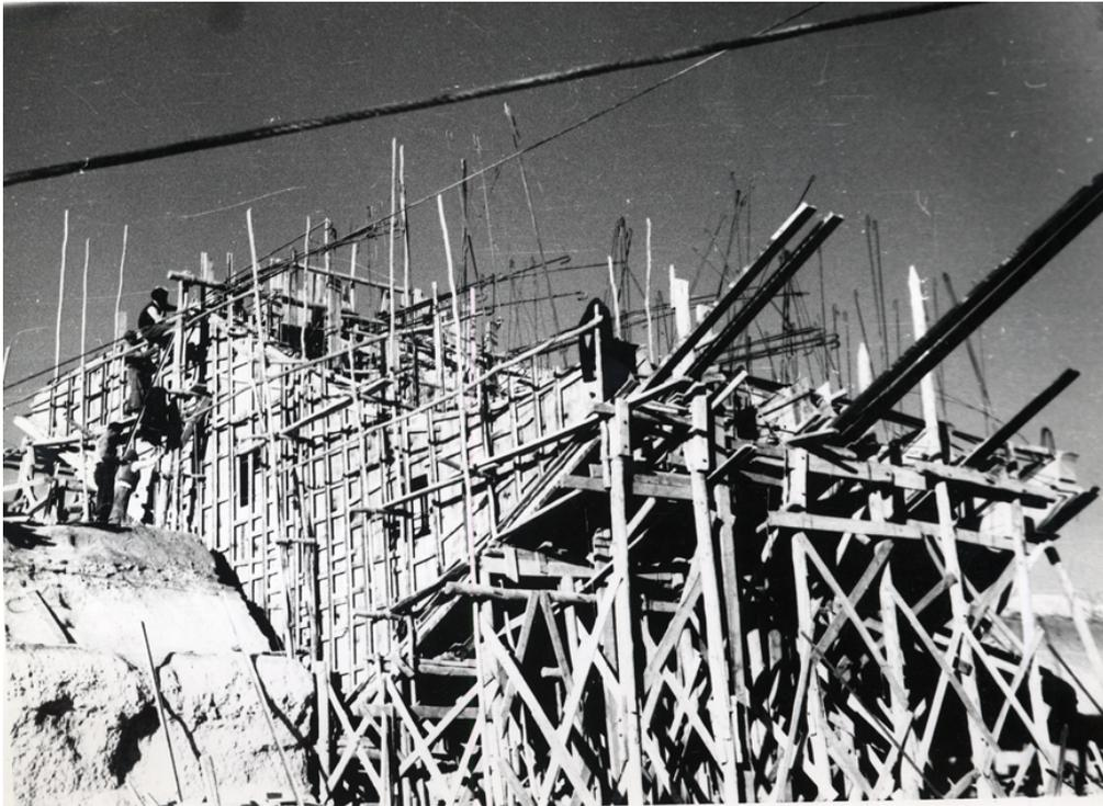
Obreros trabajando en el forjado del arranque del arco
