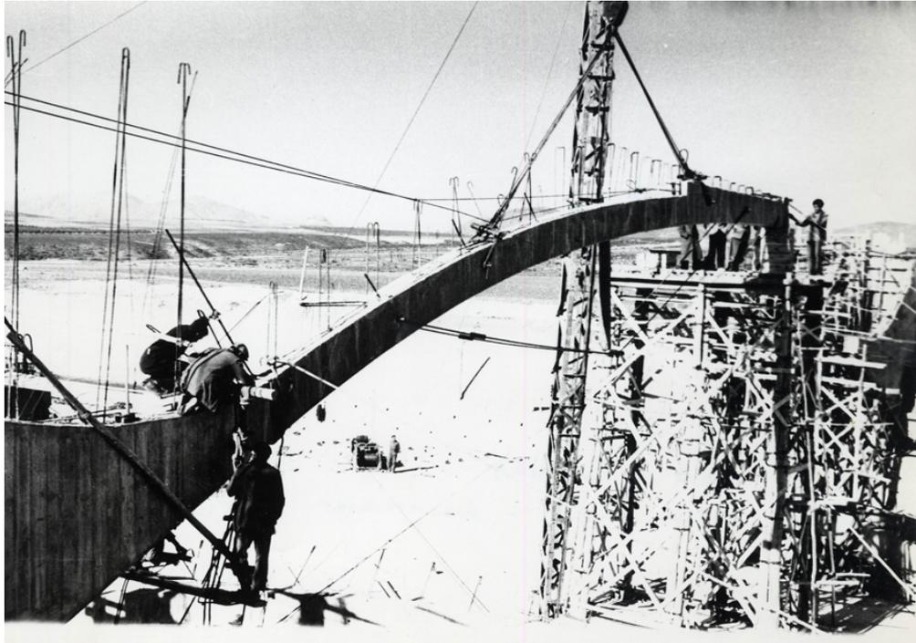
Obreros colocando la primera sección del arco
