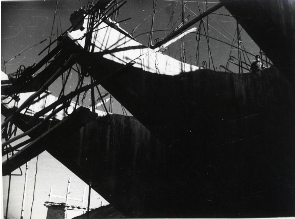
Detalle del arranque del arco en construcción
