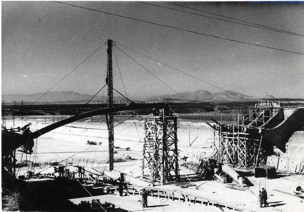
Levantamiento de las distintas partes del arco
