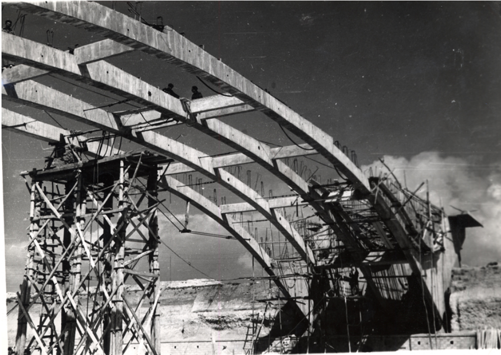
Arco en construcción
