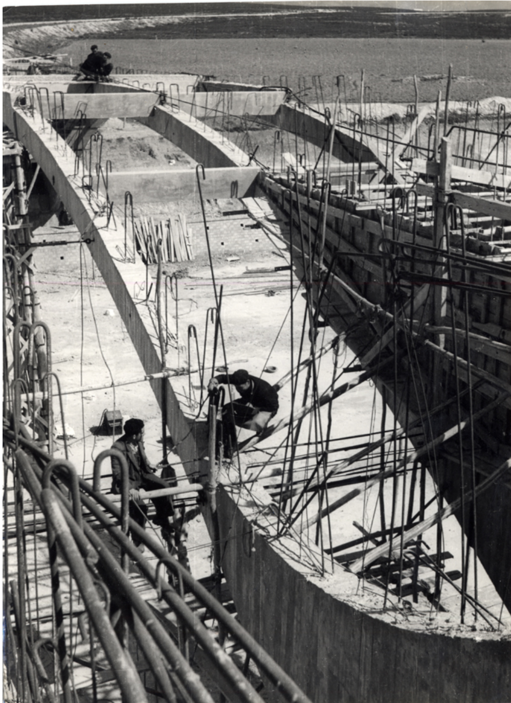
Obreros trabajando en el forjado del arco
