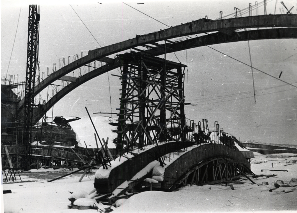
Contrucción del arco
