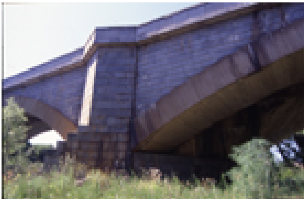
Detalle del puente
