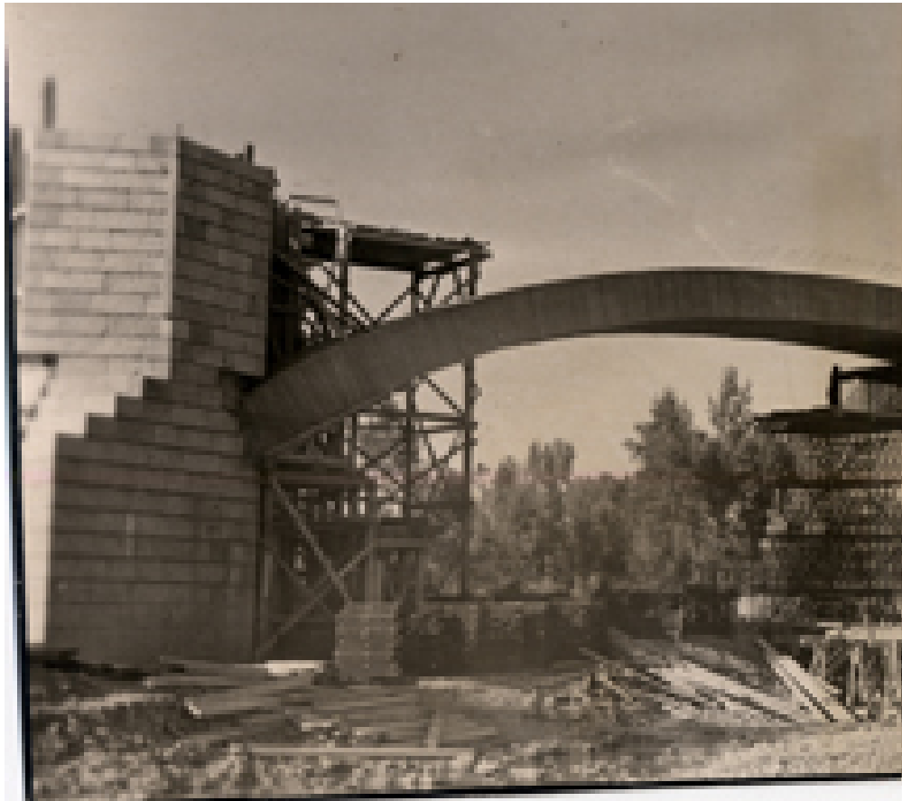
Detalle de la construcción de un arco
