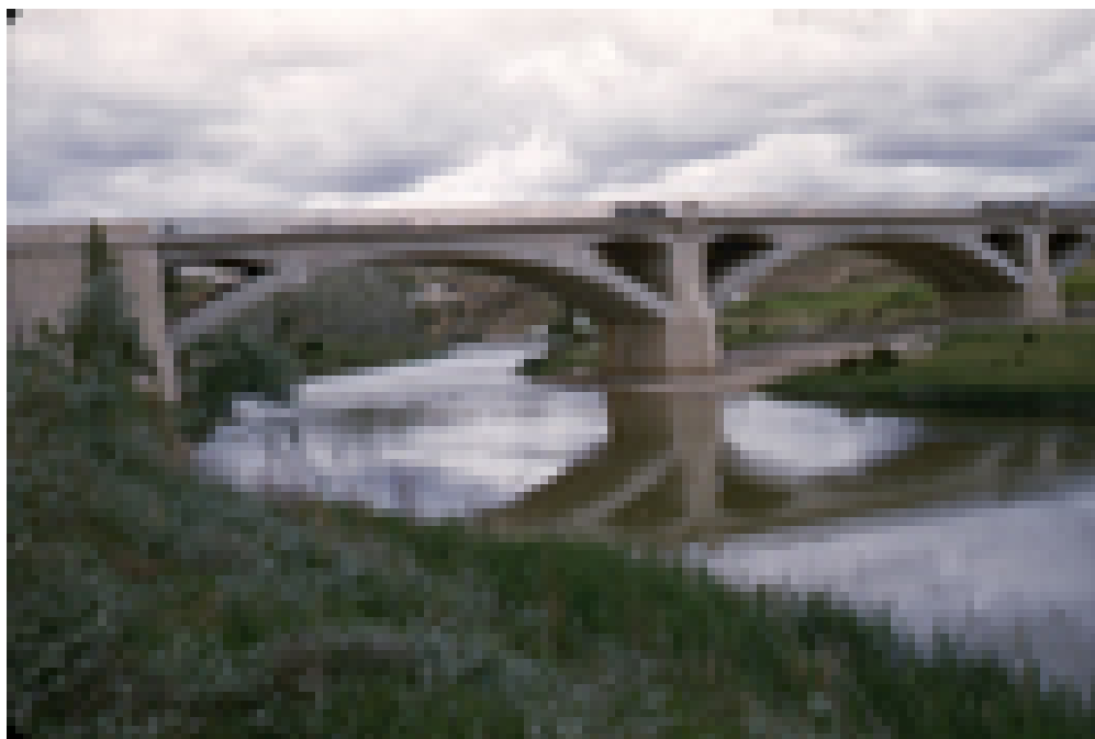
Vista del puente
