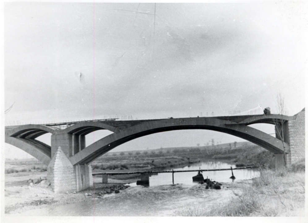
Vista del puente en construcción
