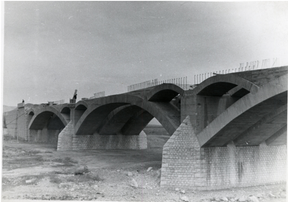
Vista del puente en construcción
