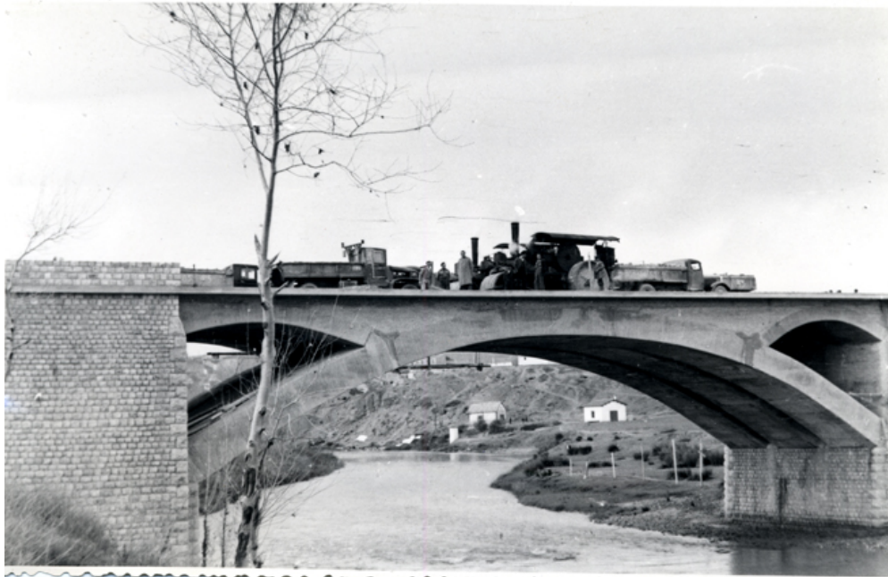
Obreros y máquinas sobre el tablero del puente
