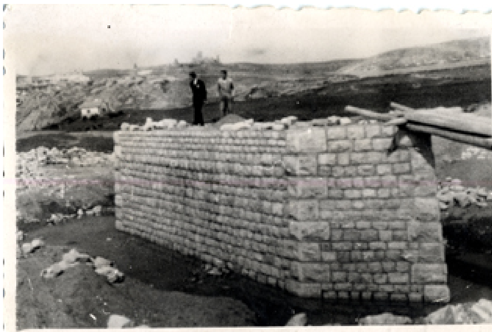
Pilar en construcción
