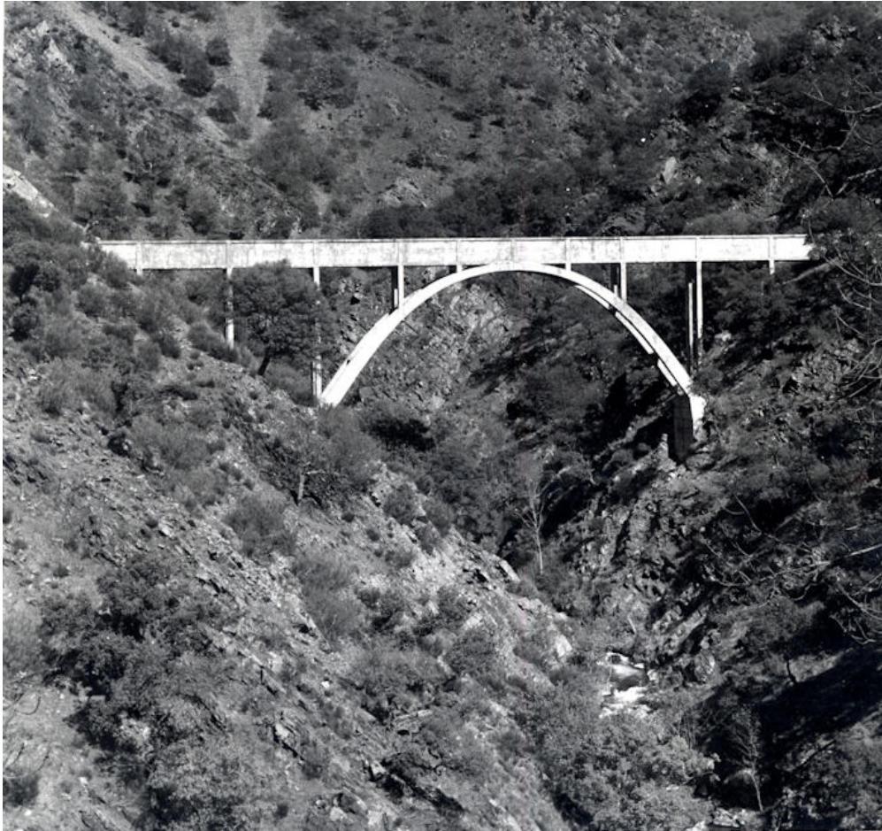
Vista general del acueducto
