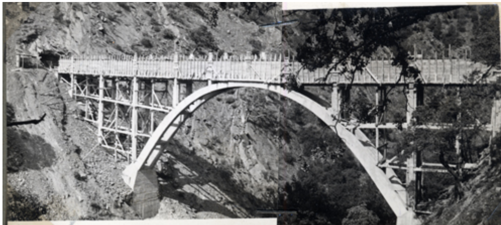
Vista del acueducto en construcción
