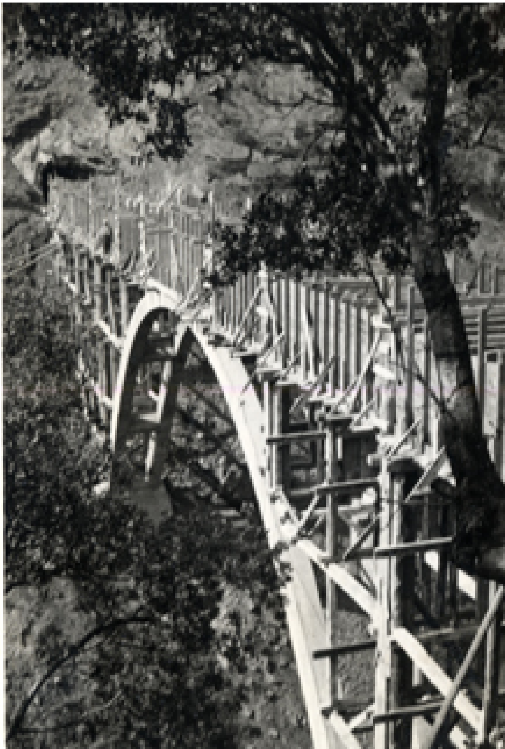
Perspectiva del acueducto en construcción
