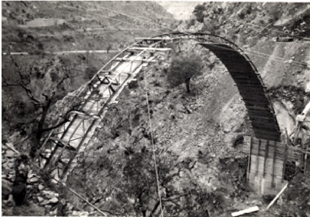
Vista del acueducto en construcción
