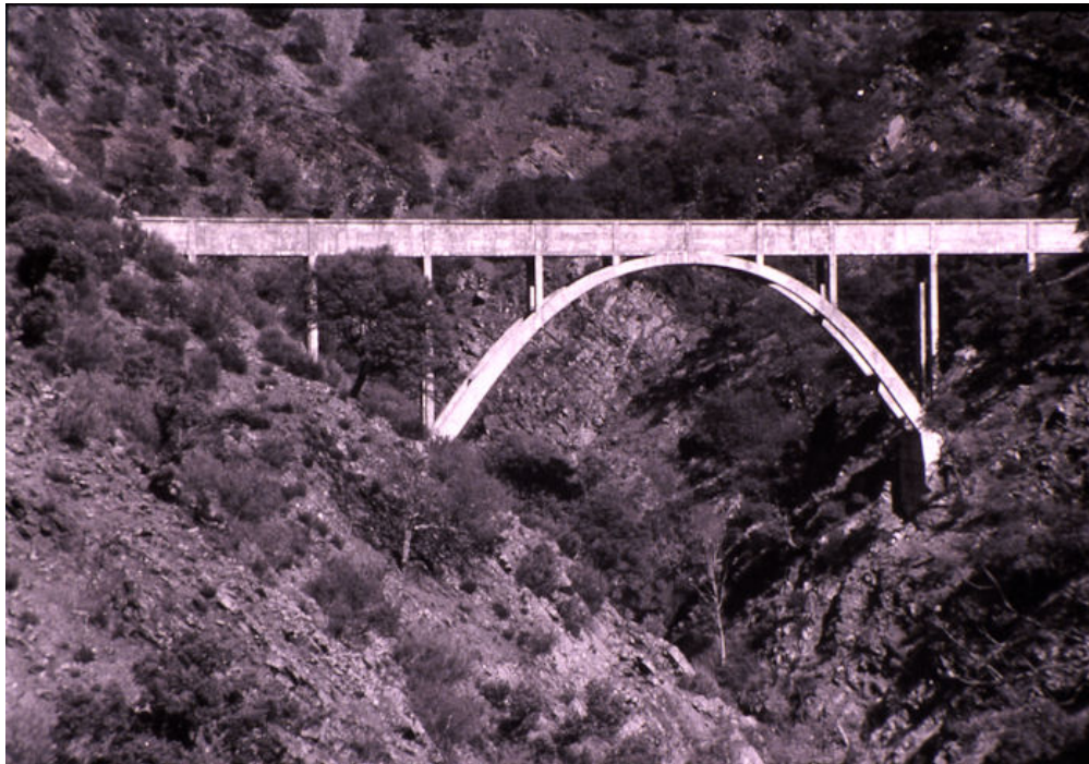
Vista general del acueducto
