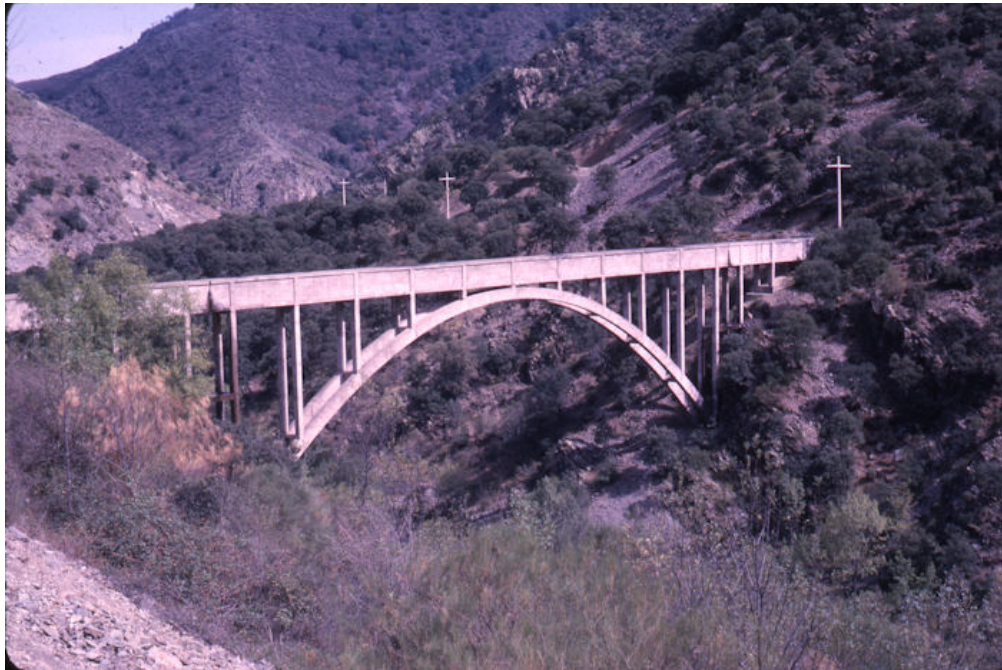
Vista del acueducto
