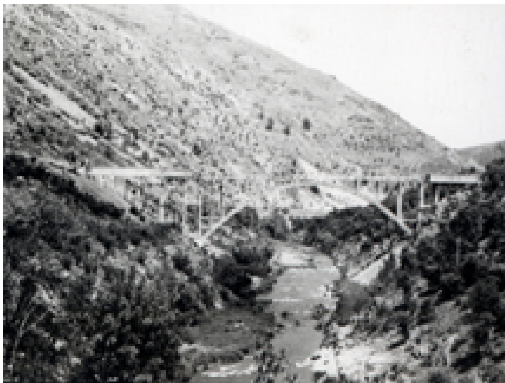
Vista del acueducto en construcción
