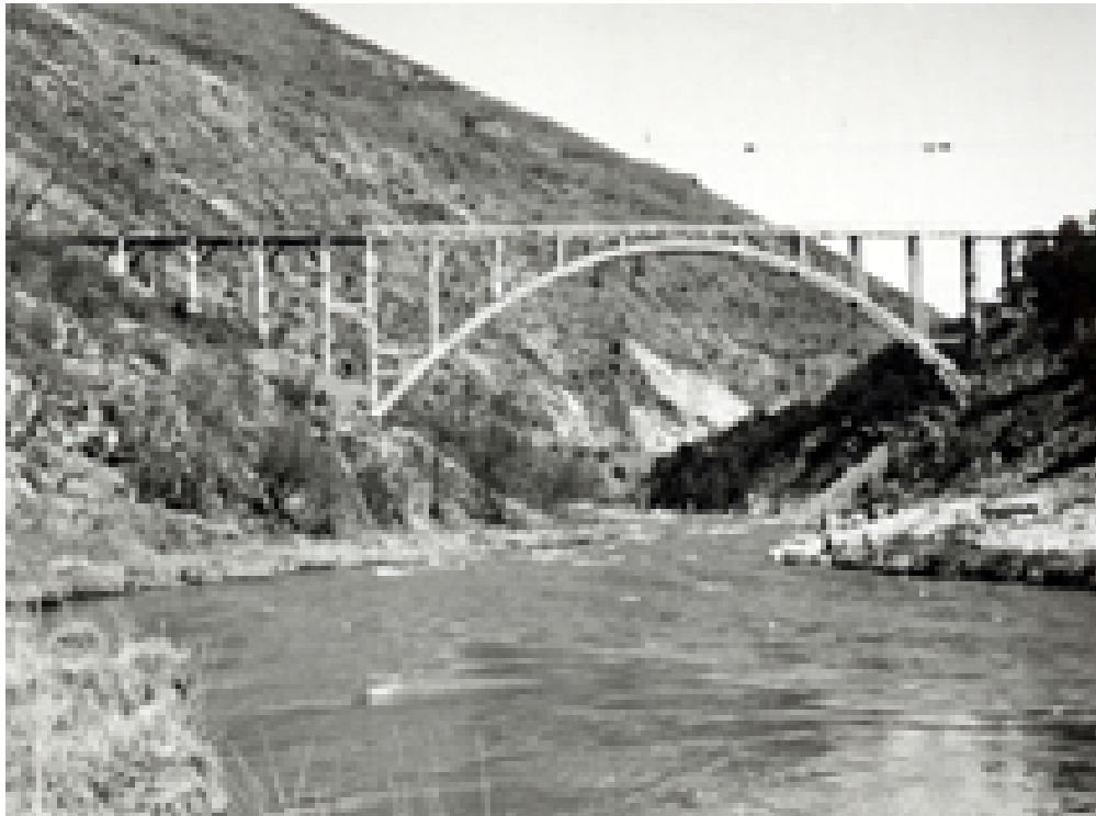
Vista del acueducto en construcción
