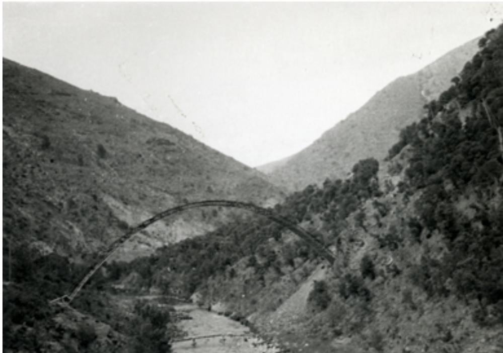
Vista del acueducto
