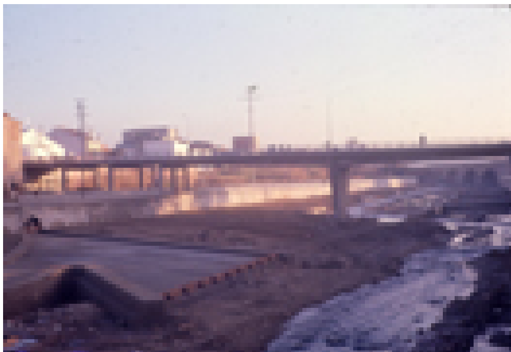
Vista del puente en Rubí sobre la riera de Rubí
