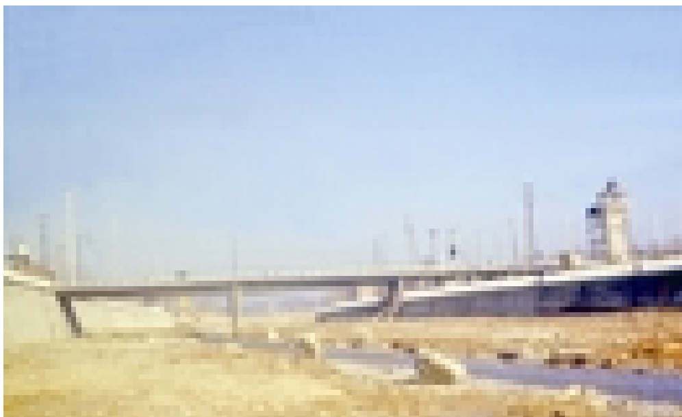
Vista general del puente "B"
