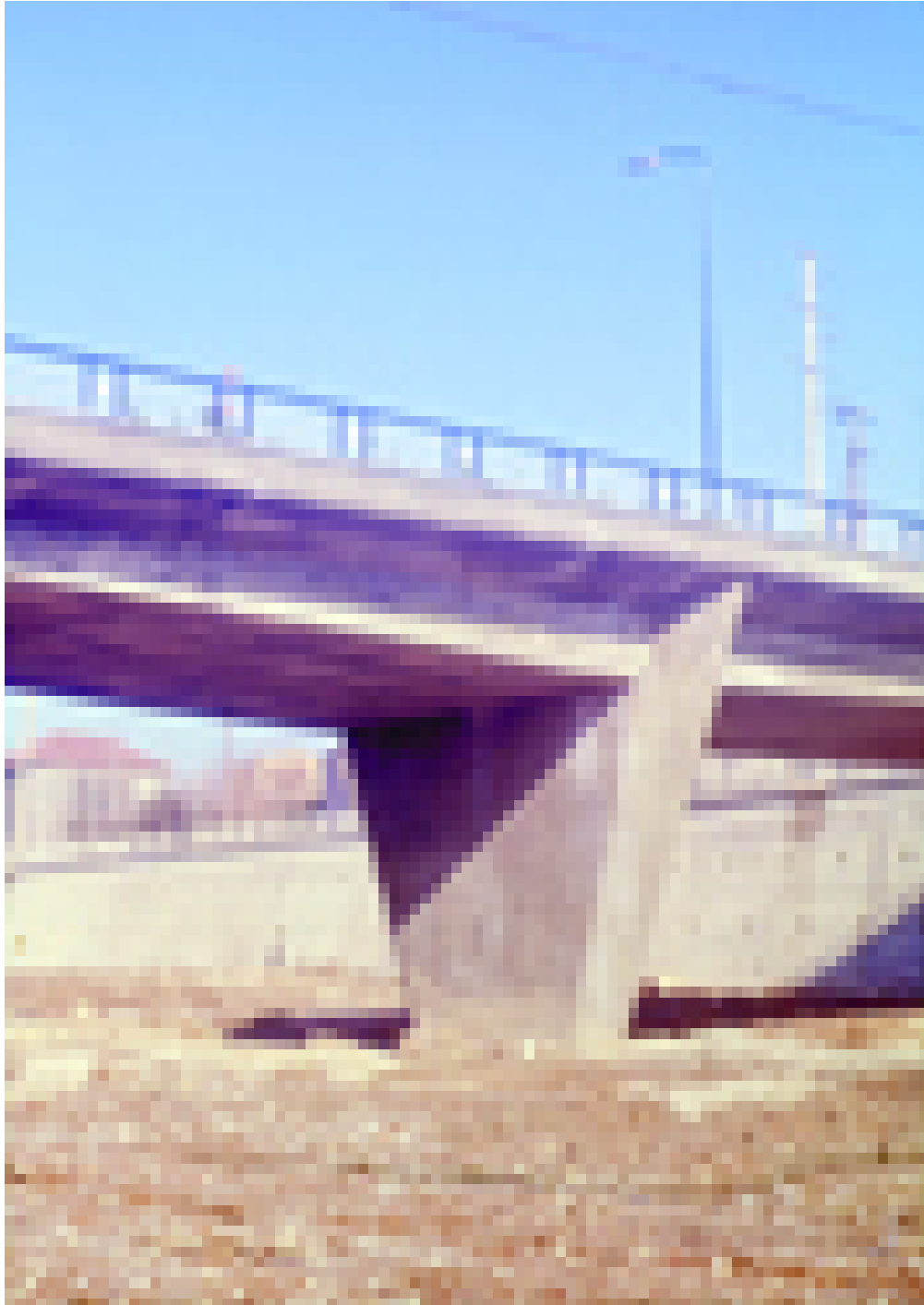
Pila central del puente "B"
