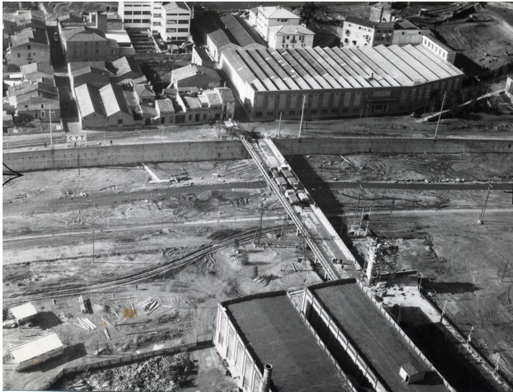
Fotografía aérea del puente "B"
