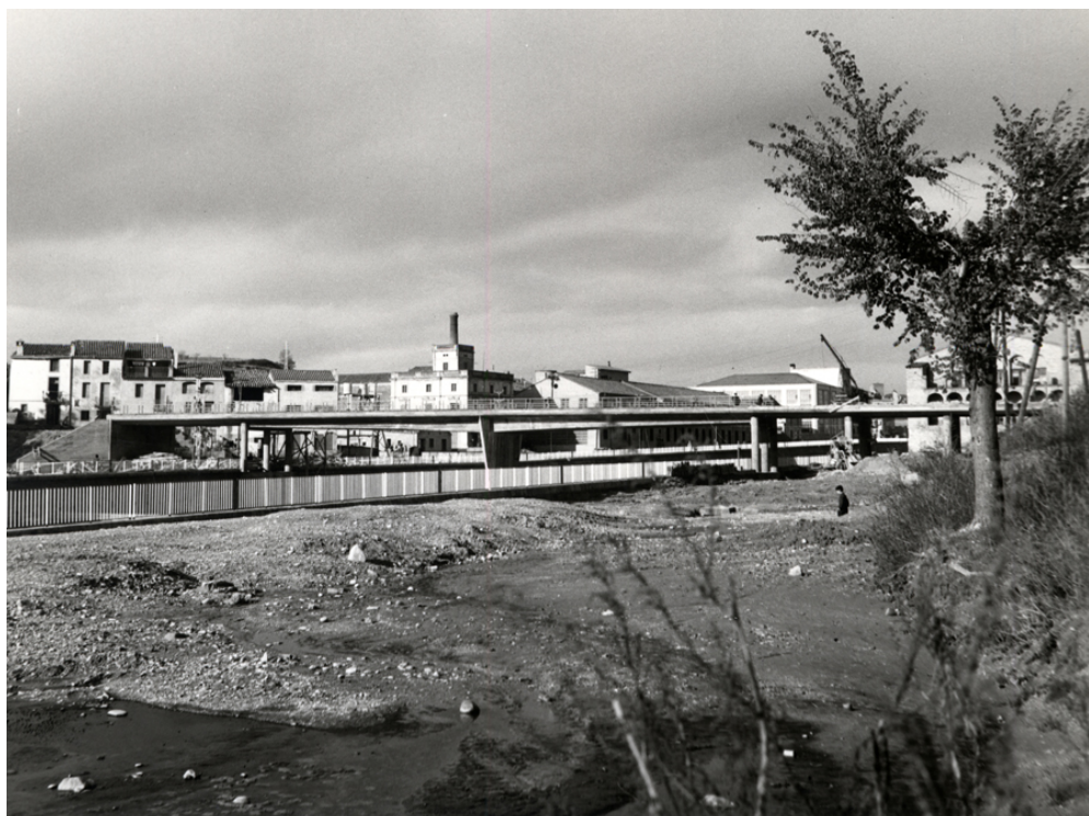
Vista general del puente "A"
