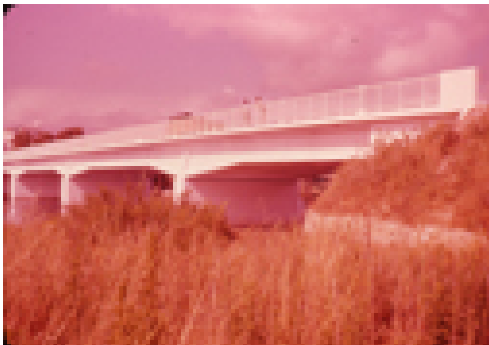
Vista del puente
