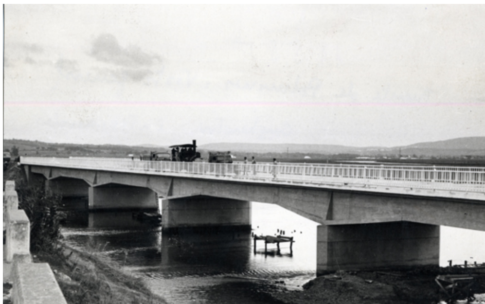
Vista del puente
