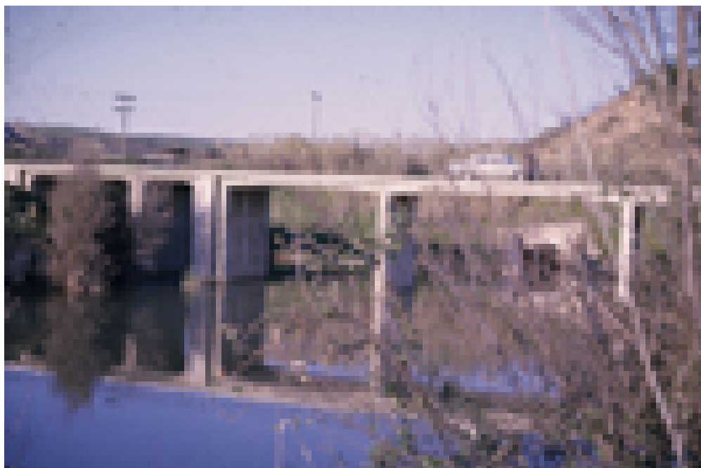
Vista del puente
