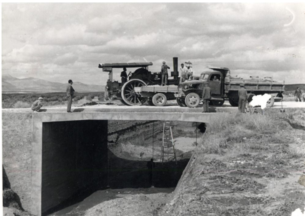
Vista del paso y vehículos
