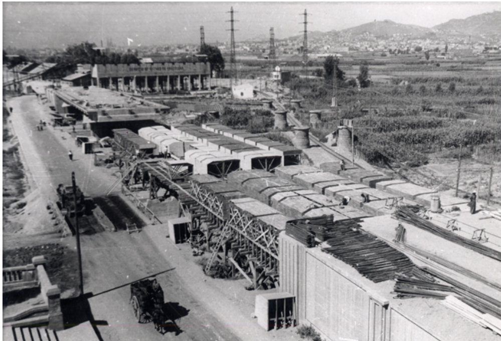
Vista aérea del puente en construcción
