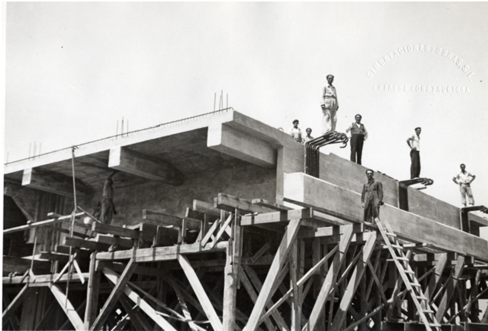
Detalle del puente en construcción
