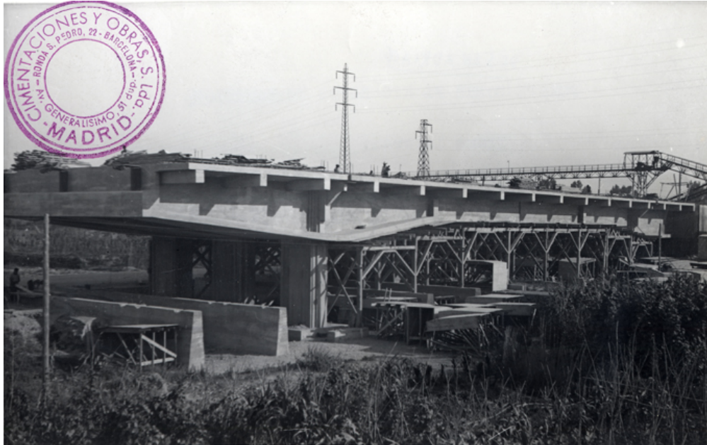
Vista del puente en construcción
