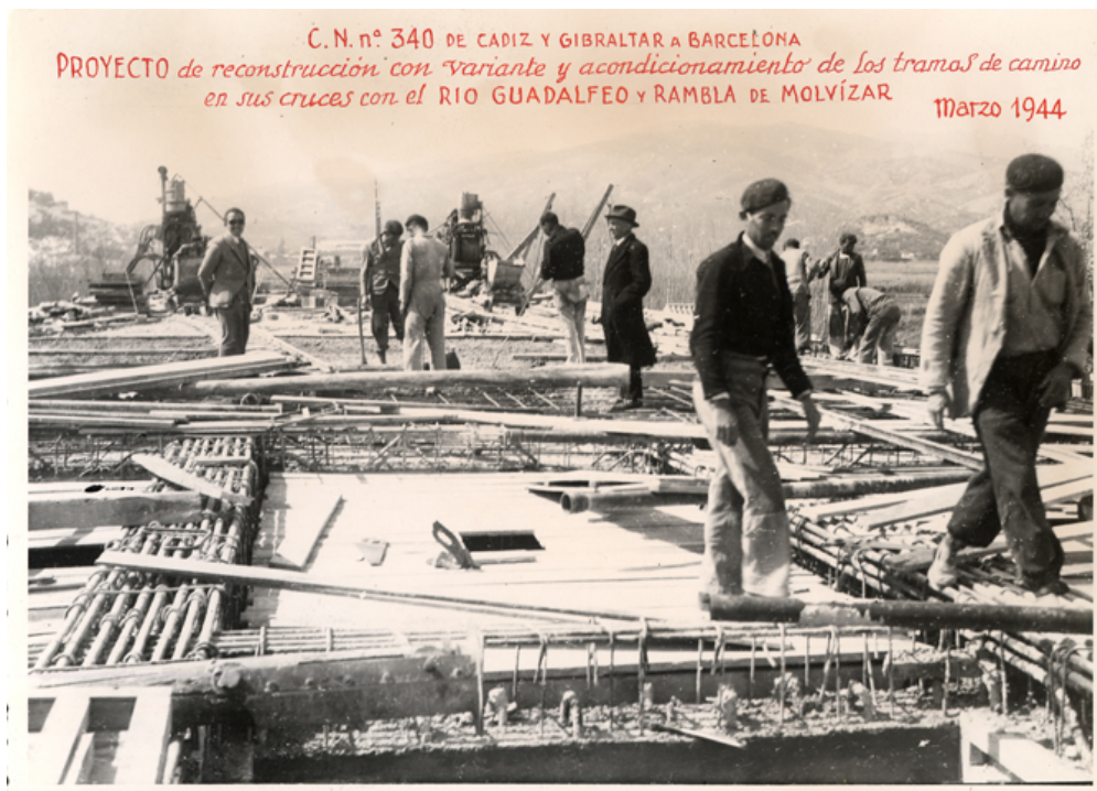
Detalle de la obra; obreros trabajando
