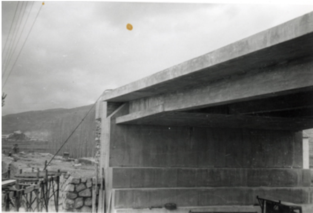
Detalle del puente
