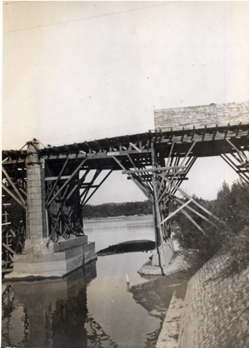
Vista de la construcción del tablero
