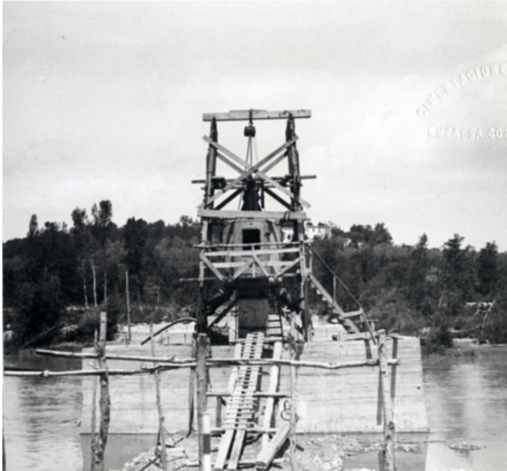
Bloque de cimentación de una pila
