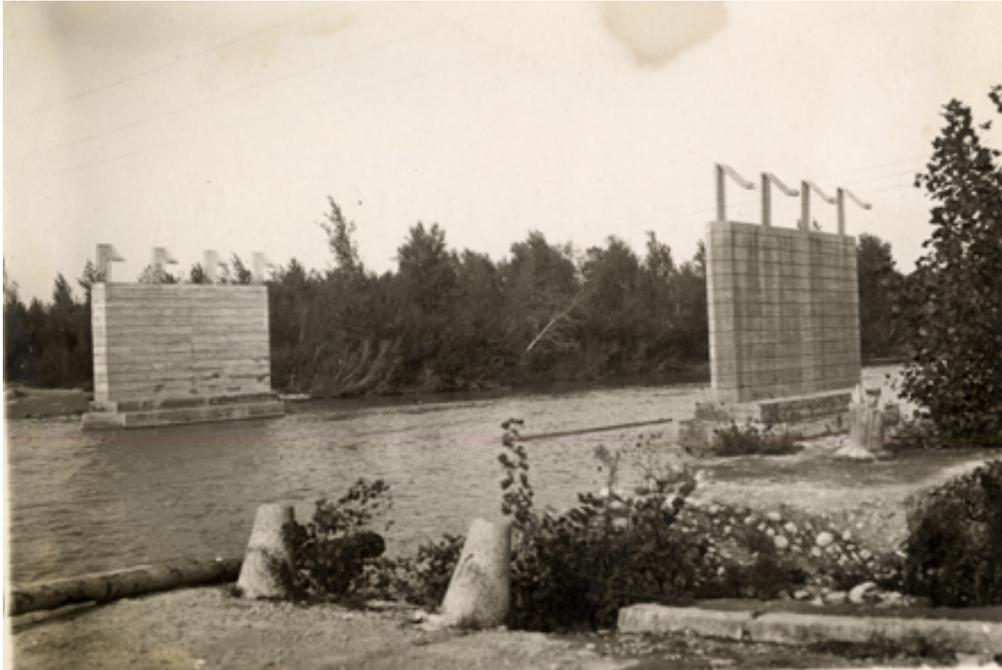
Vista de las pilas del puente en construcción
