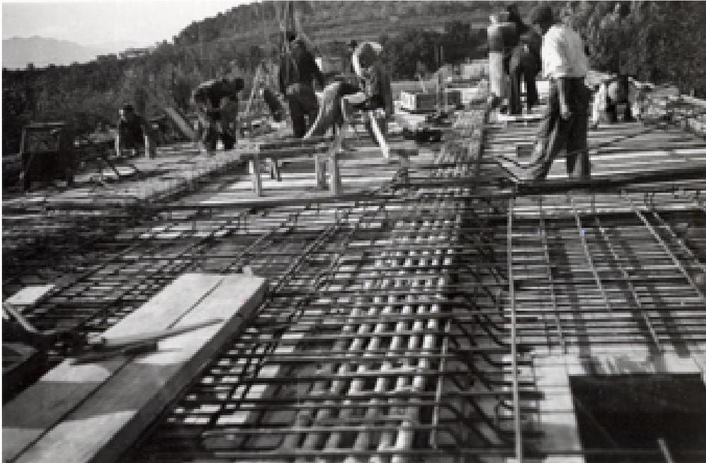
Obreros trabajando en el forjado de la estructura del puente
