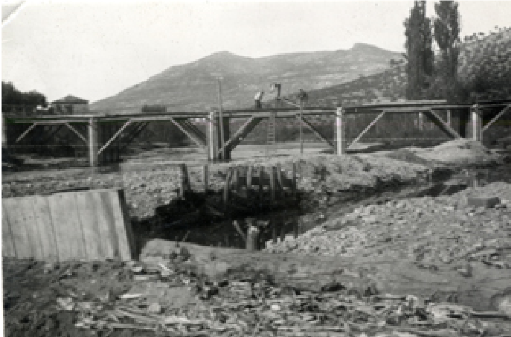
Vista del puente en construcción
