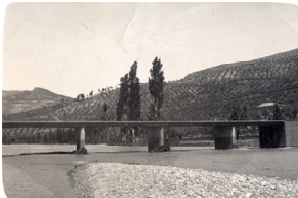
Vista del puente
