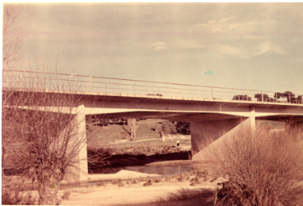
Vista del puente
