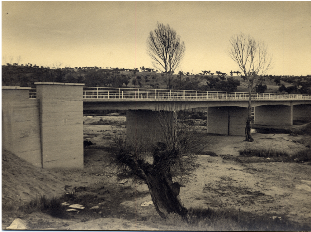
Vista del puente
