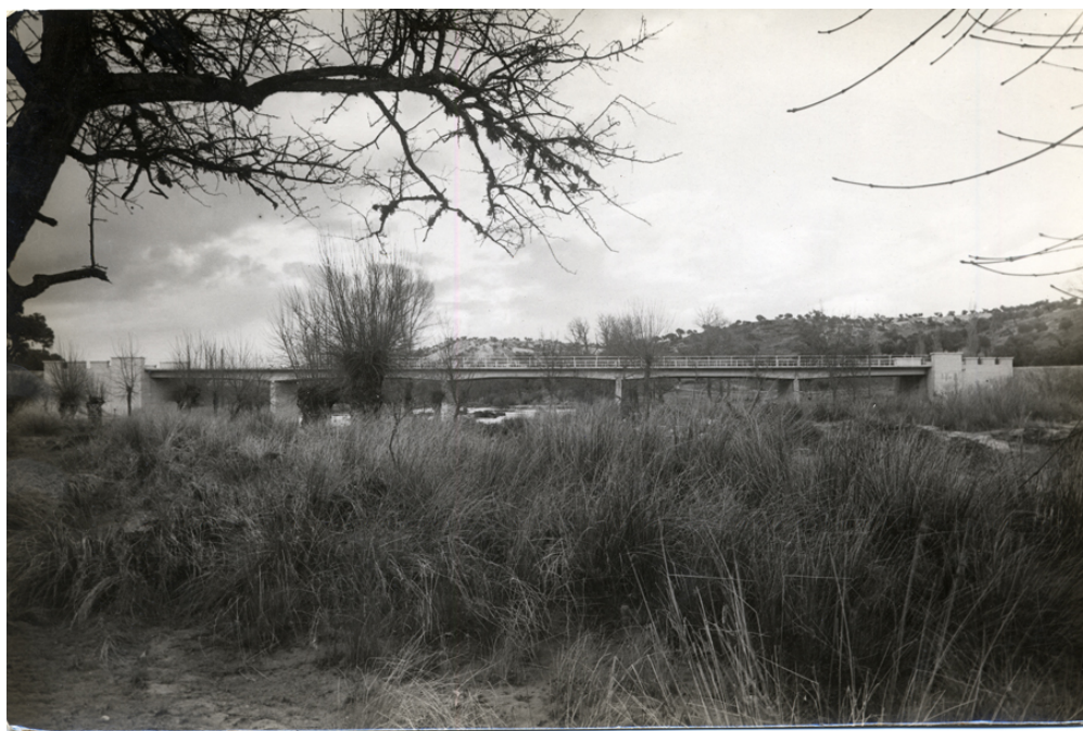
Vista del puente
