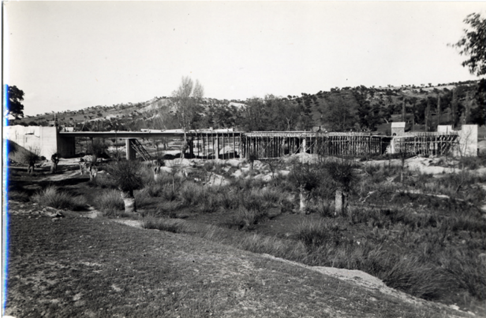
Vista del puente en construcción
