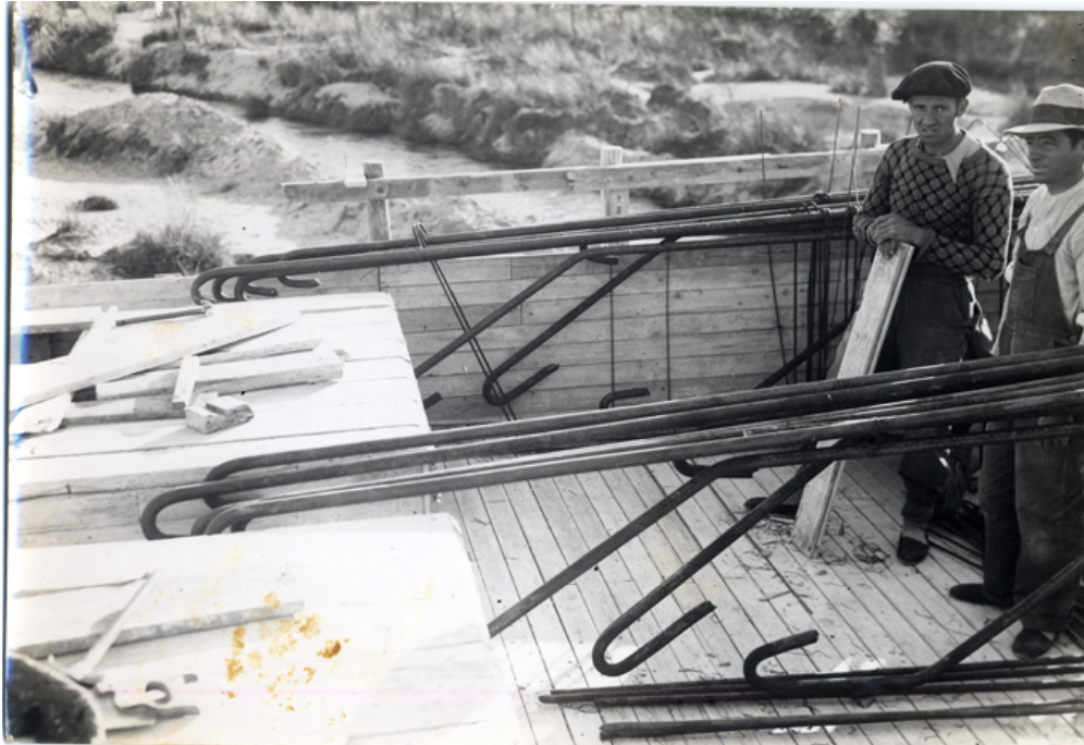
Detalle de los materiales y obreros
