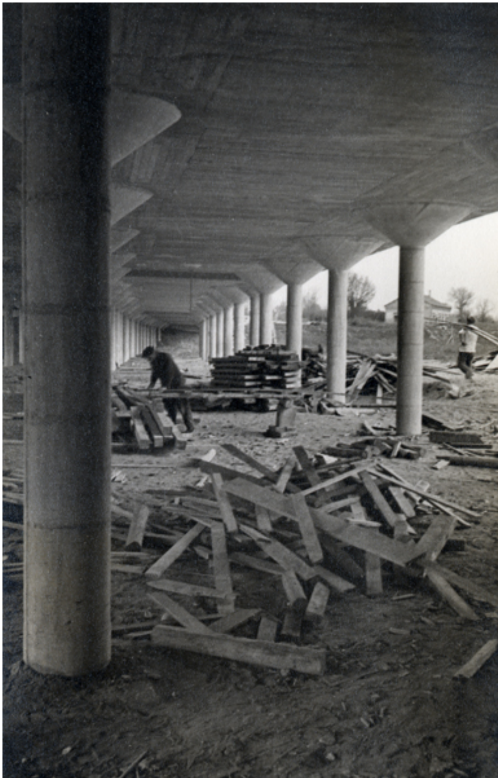
Detalle del puente en construcción
