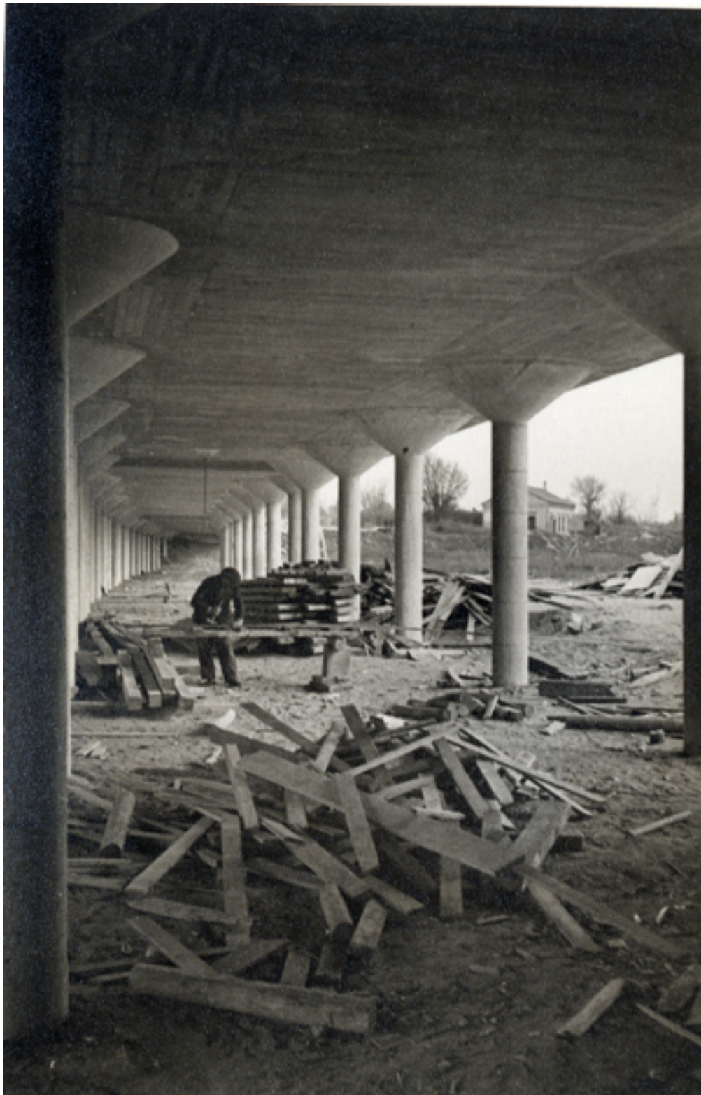
Detalle del puente en construcción
